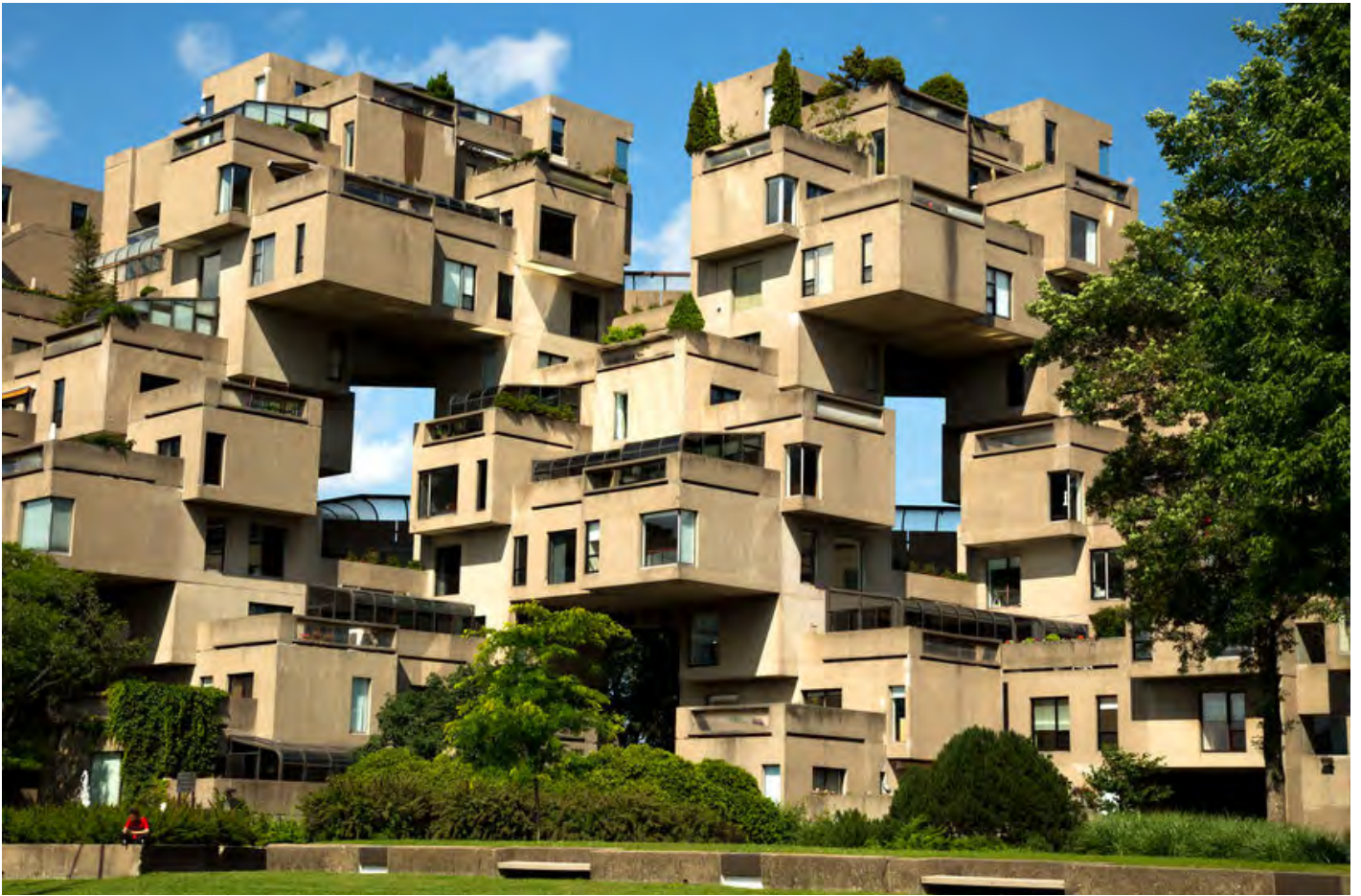
Obrázek 2: Moše Safdie – Habitat 67, méně vhodný tvar s ohledem na poměr ohřivané plochy a objemu vytápěného vzduchu (A/V – foto: building.ca)
