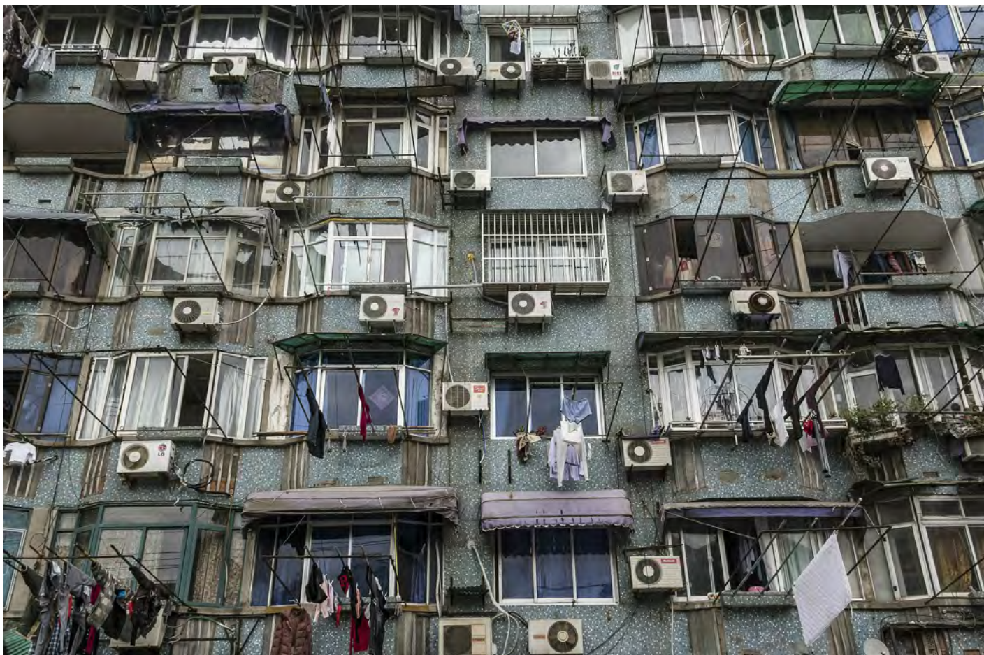
Obrázek 9: Decimující vliv klimatizačních jednotek na architekturu, foto: Pixbay
